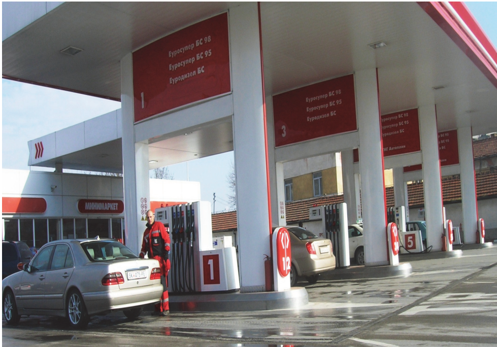
Сл. 36 Бензинска станица
